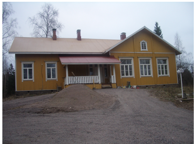
2005 syksyllä, jolloin ulkovuoraus ja ikkunat on uusittu, sekä sisäänkäynnin terassi rakennettu.
